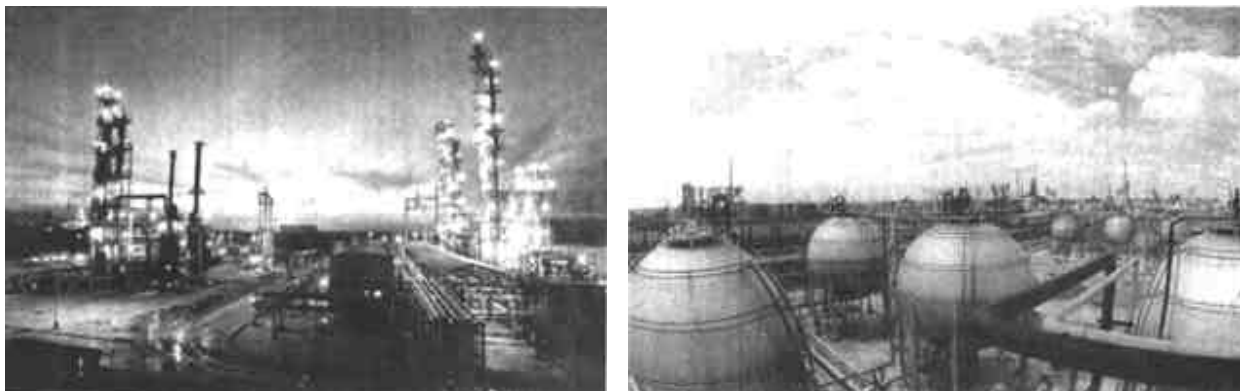
石油化工 (记者 黄利平 摄)
